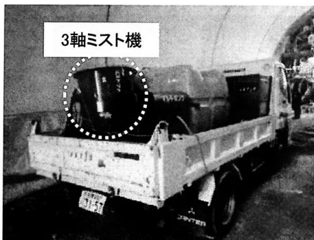
図-3 ミスト養生設備
